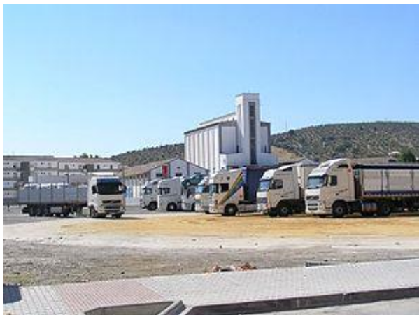
Silo de grano en Alcalá la Real ( Jaén , España ).
