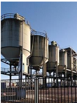
Silos metálicos de fondo cónico para guardar cemento
