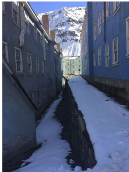
(A) Muro de contención en pendiente (B) Nivel de llegada inclinado (C) Canalización de aguas.
