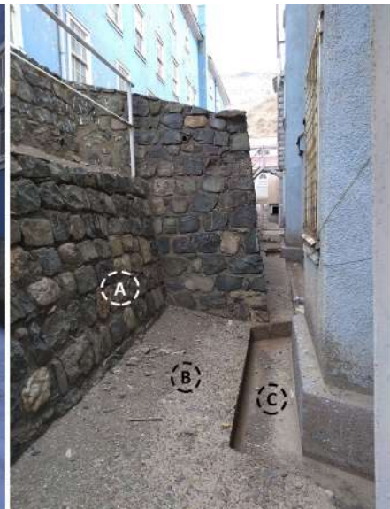
(A) Muro de contención en pendiente (B) Nivel de llegada inclinado (C) Canalización de aguas.
