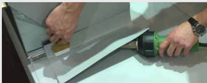
La espátula «Kehlfix» es el medio auxiliar ergonómico para el trabajo eficiente.
