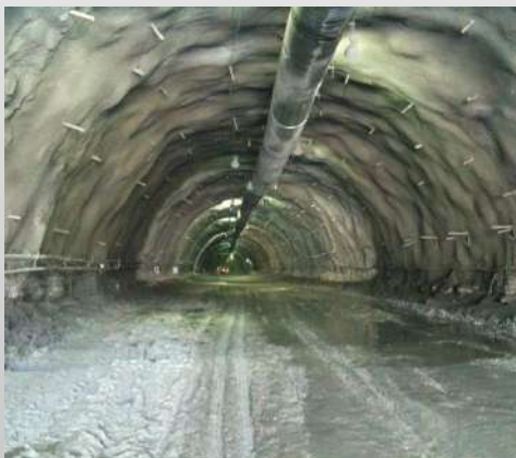
Túnel Grijalba-Shotcrete
