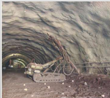
Túnel El Sinaloense
