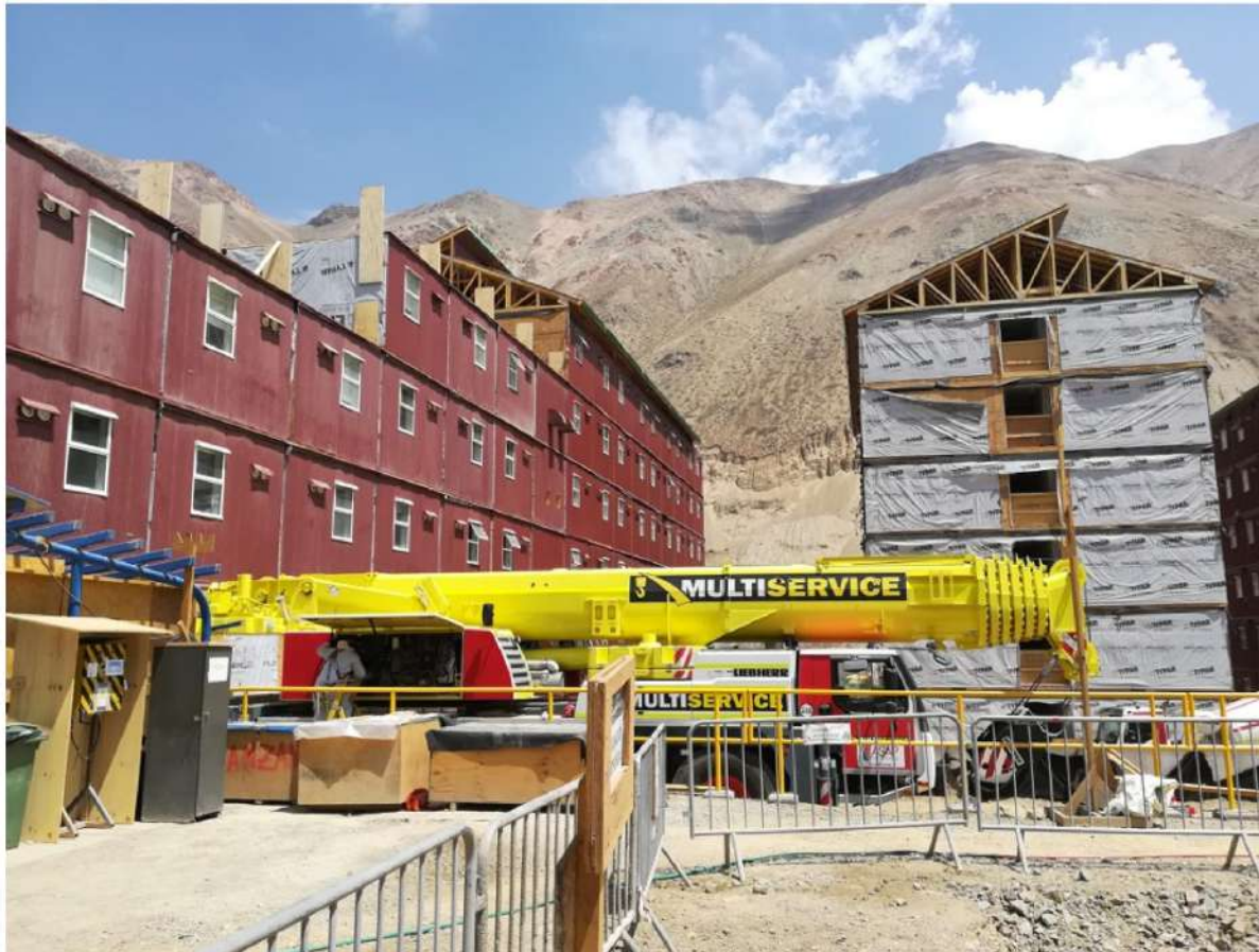
Figura 2. Equipos de construcción.
